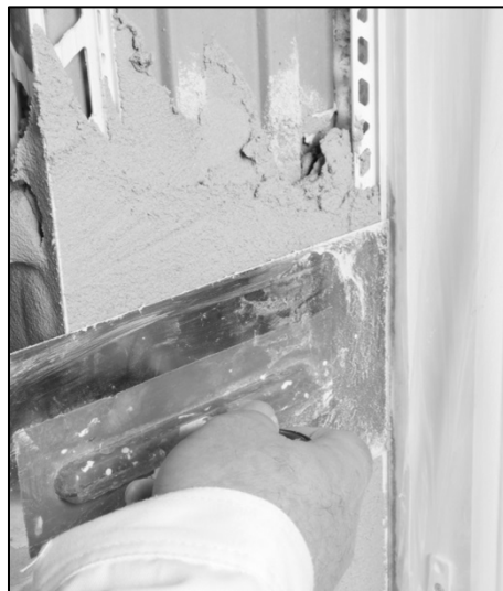
8. Verputzen. Hinterfüllung des Einputzschenkels beachten!
