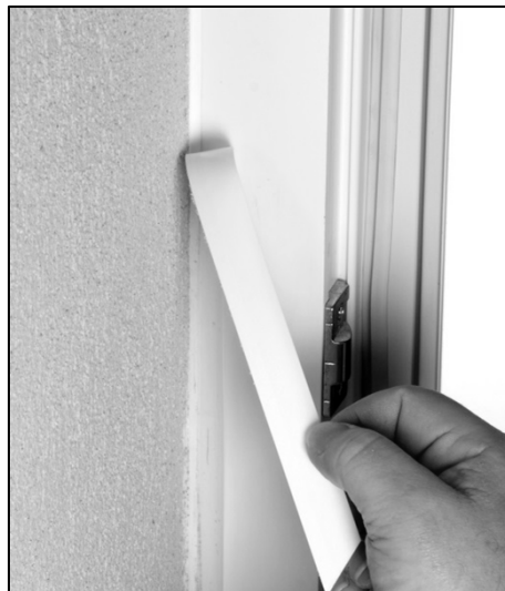
11. Abziehstreifen entfernen.
