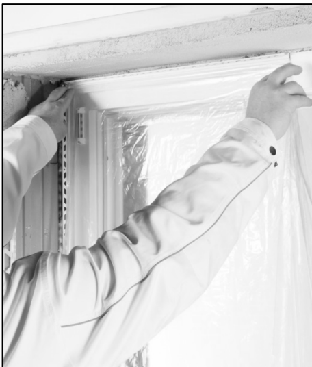
7. Verkleben der Schutzfolie.
