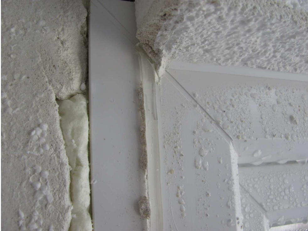
Bild 7 Demontierte Anputzdichtleiste T-FAL Dichtprofil 3797G
