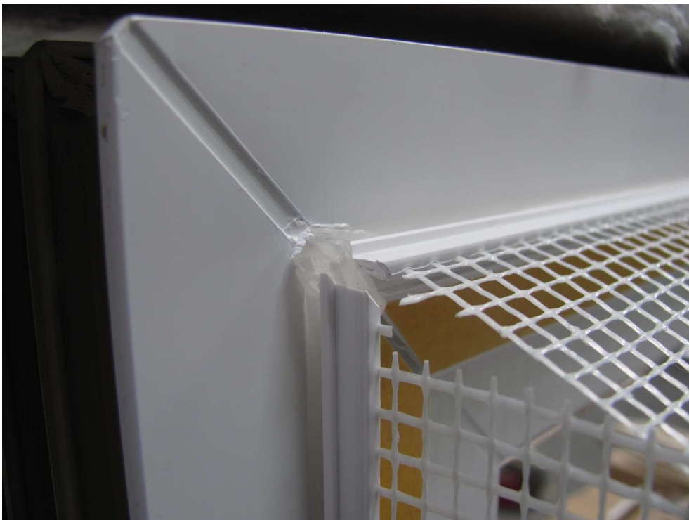
Bild 6 Detailansicht Gehrungsstoß mit Gelband
