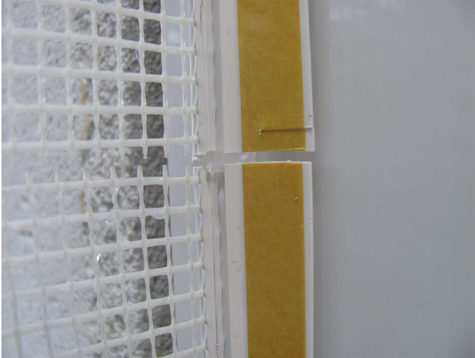
Bild 5 Detailansicht Stoß mit Gelband
