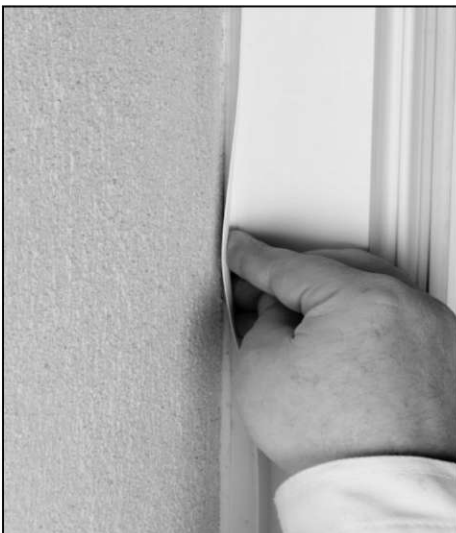
10. Nach Austrocknung des Putzes Abziehstreifen einknicken.
