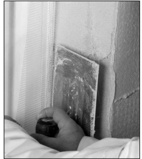
9. Bei WDVS-Profilen Gewebestreifen vollständig in die Putzschicht einarbeiten!
