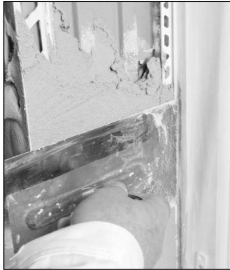
8. Verputzen. Hinterfüllung des Einputzschenkels beachten!
