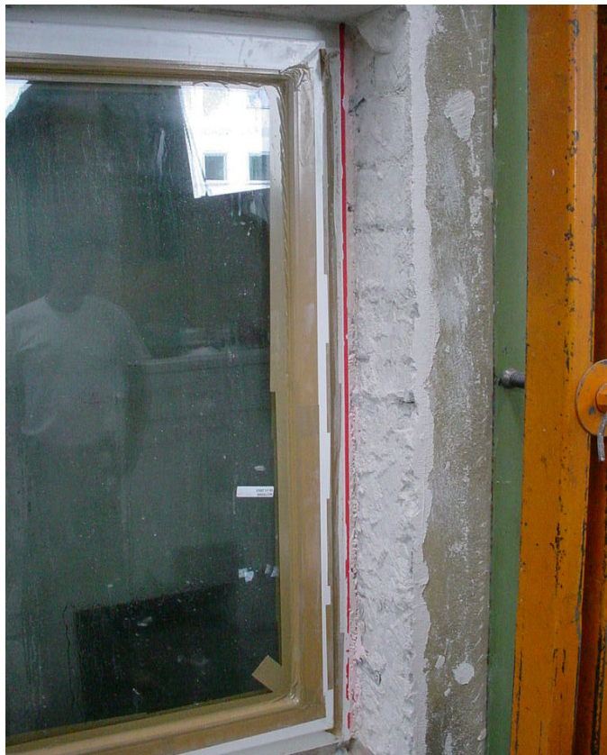
Bild 7 Ausgangsprüfung Schlagregendichtheit mit freigelegter raumseitiger Leibung.
