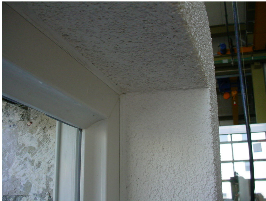
Bild 4 Oberes Eckdetail T-FAL-Dichtsystem außen (WDVS) nach Fertigstellung des WDVS.
