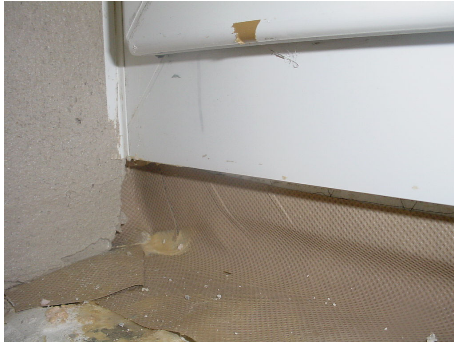
Bild 3 Untere Eckausbildung, im Brüstungsbereich 3line-Brüstungsband.
