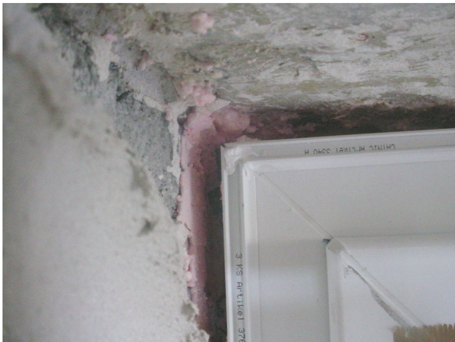
Bild 2 Obere Eckausbildung T-FAL-Dichtsystem innen.
