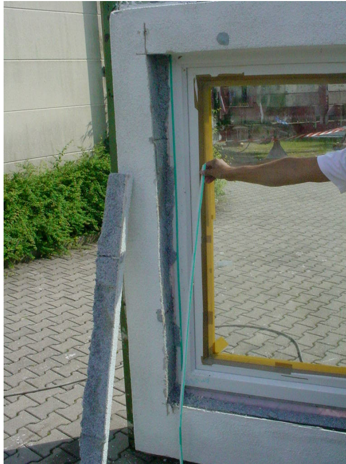
Bild 8 Nach Abschluss der Prüffolge äußere Leibungen zur abschließenden Untersuchung geöffnet.
