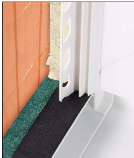
8. Übergang T-FAL® Dichtprofil Gel zur 3win Fensterbank schlagregendicht ausführen (z.B. mit Fugendichtband)
