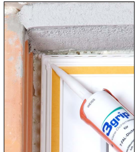
12. Abdichten alle Stöße der T-FAL® Dichtprofile Gel mit 3grip Klebe-Dichtmasse
