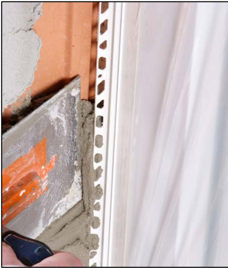
13. Verputzen Hinterfüllung des Einputzschenkels beachten!
