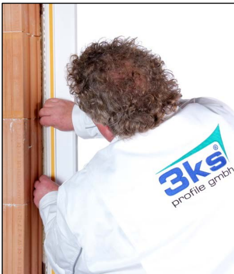
7. Spannungsfreies Ankleben der T-FAL® Dichtprofile Gel (von einem Ende des Profils zum anderen)
