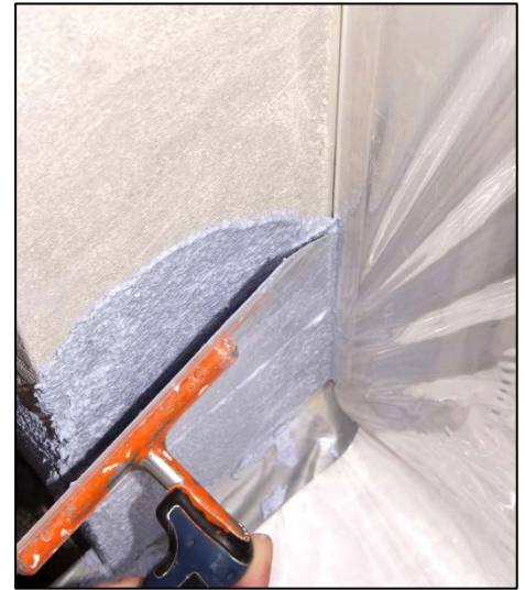
15. Zwei Abziehanten für Grund- und Edelputz nutzen
