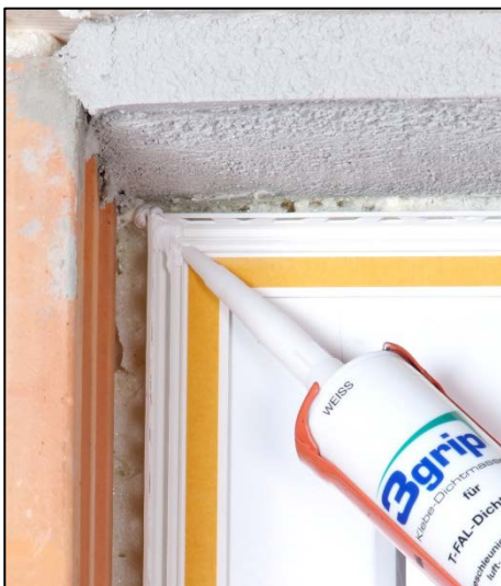
10. Abdichten alle Stöße der T-FAL® Dichtprofile Gel mit 3grip Klebe-Dichtmasse
