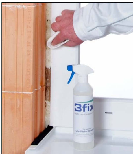
4. Reinigen der zu beklebenden Oberflächen mit 3fix Haftverbesserer
