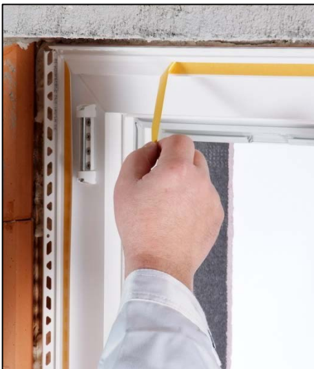
13. Entfernen des Abdeckpapiers vom Abziehstreifen
