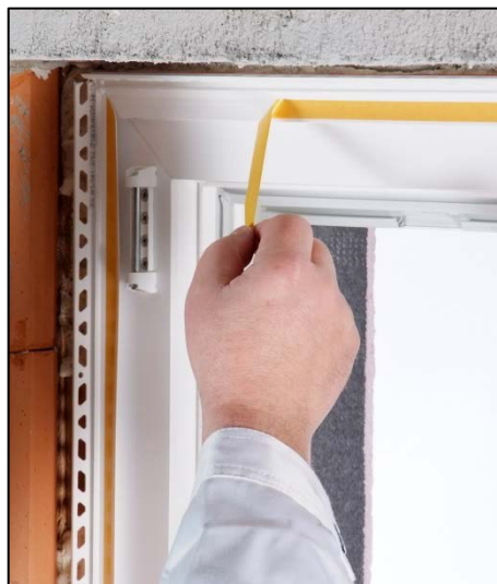
11. Entfernen des Abdeckpapiers vom Abziehstreifen
