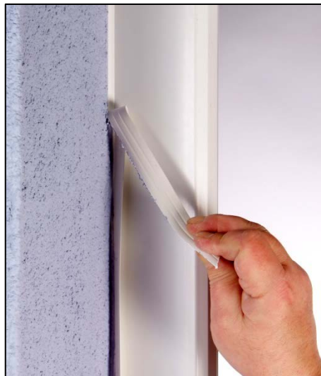
17. Abziehstreifen entfernen
