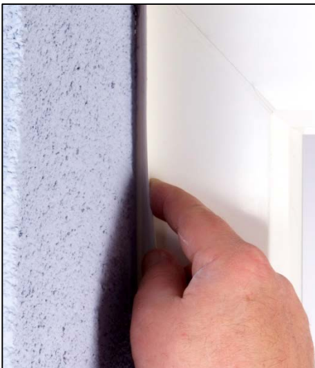
16. Nach Austrocknung des Putzes Abziehstreifen einknicken
