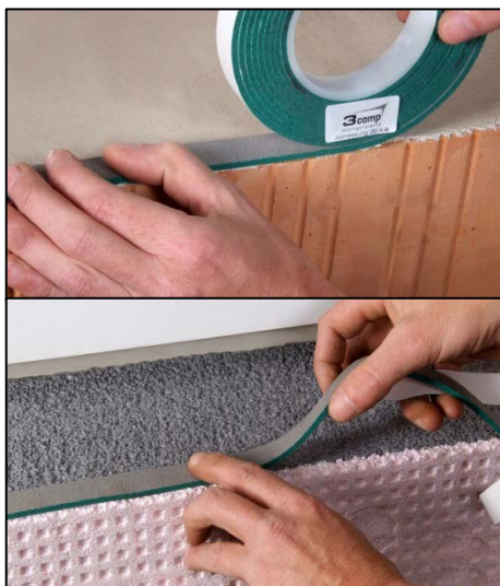
2. Aufkleben des 3comp Dichtband an der Außenkante des Mauerwerks / WDVS
