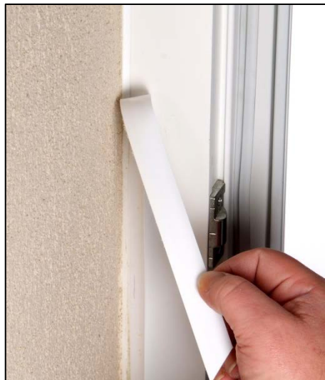
17. Abziehstreifen entfernen
