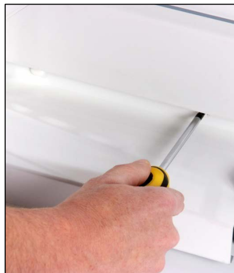
3. Anschrauben der 3win Fensterbank am Fensterbankanschlussprofil
