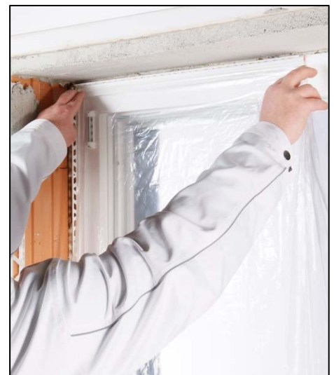
12. Verkleben der Schutzfolie
