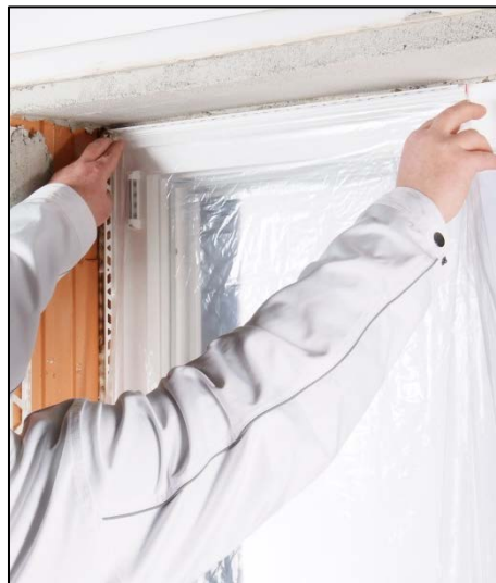
14. Verkleben der Schutzfolie
