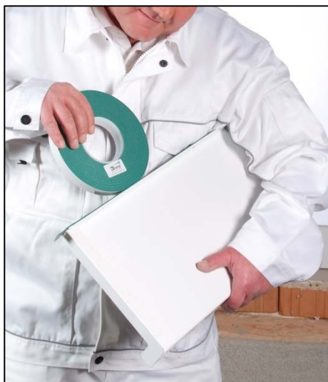
1. Aufkleben des 3comp 20/2 Dichtbandes am Anschraub-Steg der 3win Fensterbank . (li. u. re. ca. 2 cm Überlänge)
