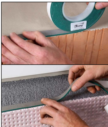
2. Aufkleben des 3comp Dichtbandes an der Außenkante des Mauerwerks / WDVS.
