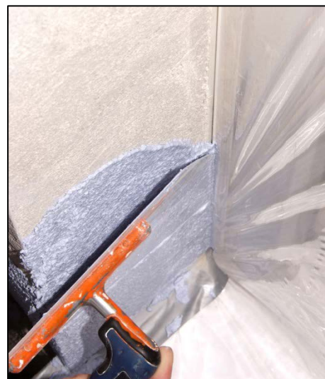
15. Zwei Abziehanten für Grund- und Edelputz nutzen.
