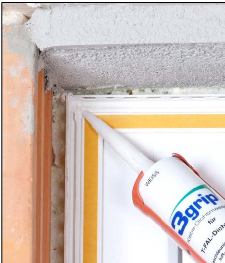
10. Abdichten alle Stöße der T-FAL® Dichtprofile mit 3grip Klebe-Dichtmasse.
