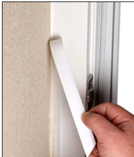
17. Abziehstreifen entfernen.
