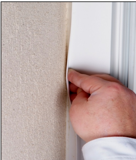
16. Nach Austrocknung des Putzes Abziehstreifen einknicken.
