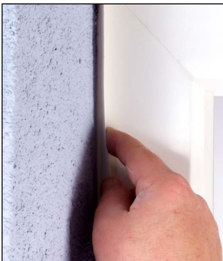
16. Nach Austrocknung des Putzes Abziehstreifen einknicken.
