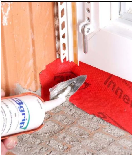
10. Luftdichtes Verkleben der Eckausbildung.
