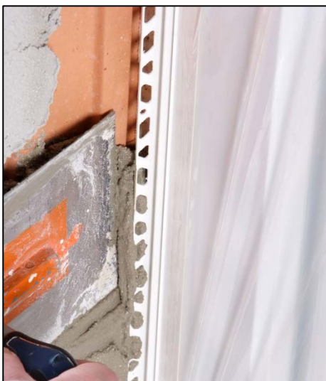
13. Verputzen. Hinterfüllung des Einputzschenkels beachten!
