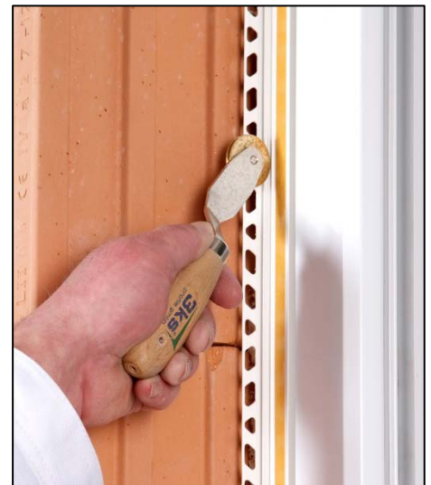
9. Andrücken der T-FAL® Dichtprofile mit T-FAL® Andrückrolle.
