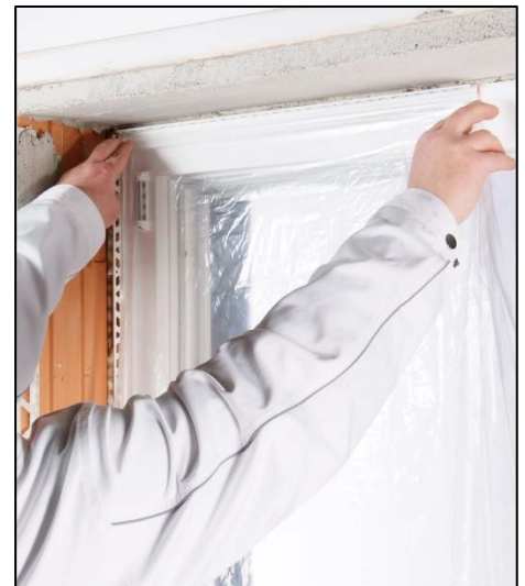
12. Verkleben der Schutzfolie.
