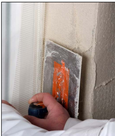
14. Bei WDVS-Profilen Gewebestreifen vollständig in die Putzschicht einarbeiten!
