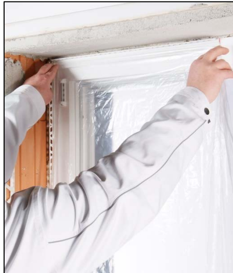
14. Verkleben der Schutzfolie.
