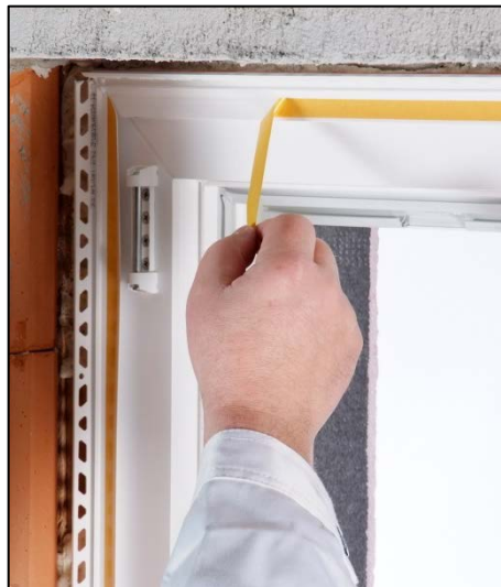
11. Entfernen des Abdeckpapiers vom Abziehstreifen.
