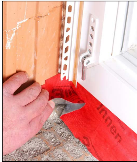
8. Übergang zur Laibung überlappend ausführen.
