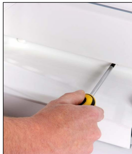
3. Anschrauben der 3win Fensterbank am Fensterbankanschlussprofil.
