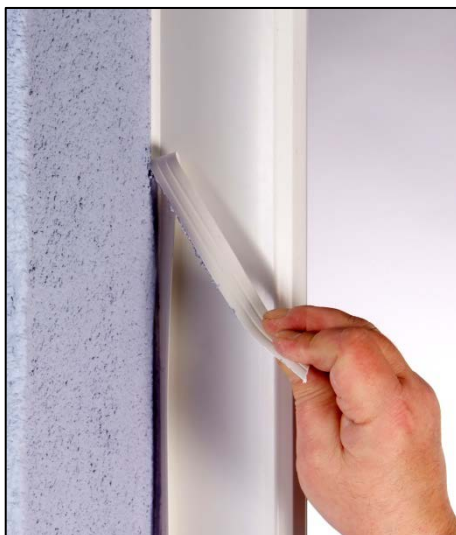
17. Abziehstreifen entfernen.
