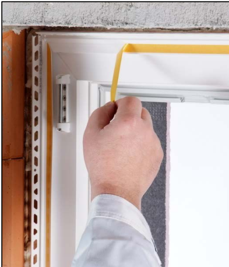
13. Entfernen des Abdeckpapiers vom Abziehstreifen.
