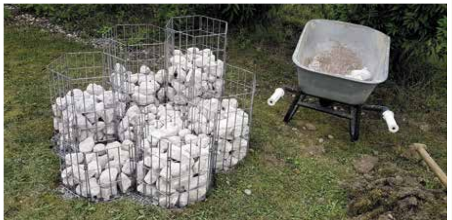
Mit Steinen befüllen
